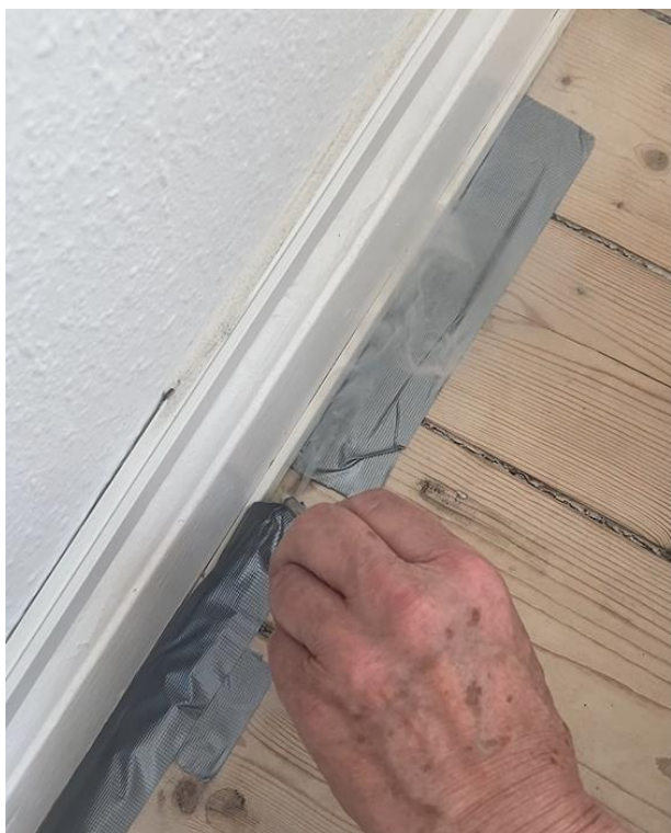
Figur 2: Brug af røgpind ved fodpaneler i stuen ind mod gården på 4.sal
